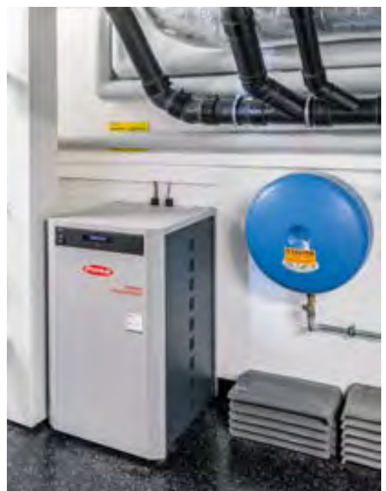
Luft-Wasser- Wärmepumpe LWZ 504 von STIEBEL ELTRON AG
